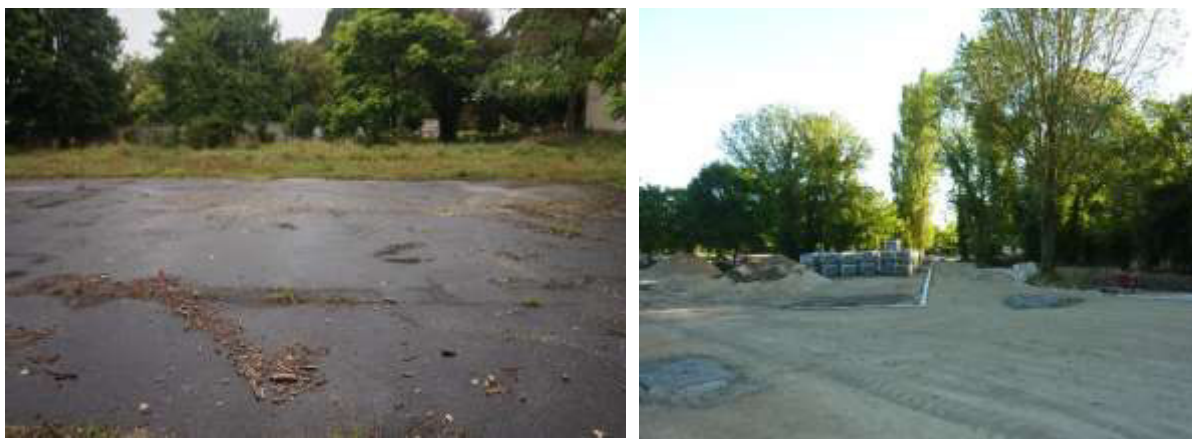
Figure 5- Photographies de la zone camping-car en 2021 avant les travaux (à gauche) et en 2022 pendant les travaux (à droite)
