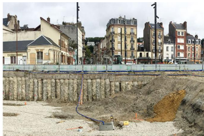
Exemple de murs en pieux sécants
