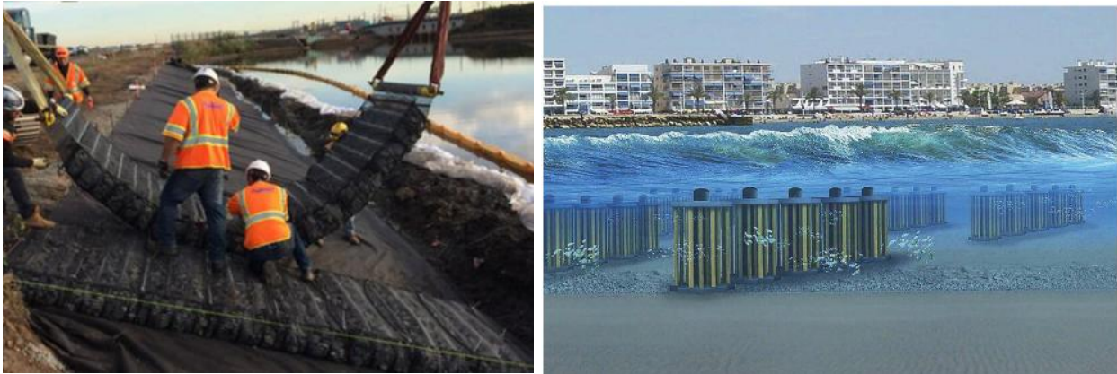
Exemples de gabions matelas (à gauche) et modules biomimétiques (à droite)
