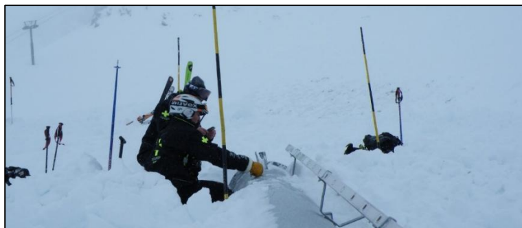
Figure 6 – Vue du pylône du Catex couché après l'avalanche
