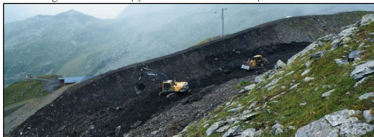
Figure 7 – Vue des travaux d'allongement de la digue en 2016 (source : service des pistes) pour obtenir les pointillés noirs de la Figure 5
