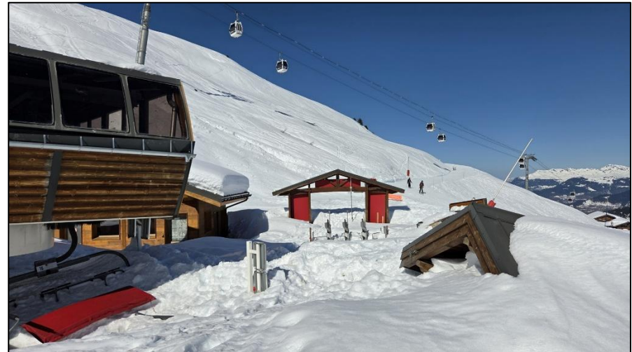
Figure 21 – Vue de l'arrière de la G12006 après l'avalanche du 17 février 2026 (photo prise 10 jours plus tard [1]). A gauche, chalet reconstruit suite à l'avalanche de 2021
