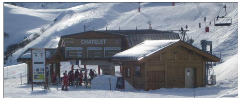
Figure 11 - Vue en exploitation normale de la G 12006 et du chalet (à droite) détruit en exploitation normale (source : www.remontees-mecaniques.net )
