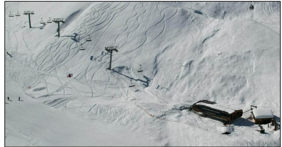
Figure 40 – De droite à gauche, vue des P2 2006 = P2 bis(2027) , P3 et P4 du TSD Châtelet (photo prise lors de [1] avec donc P1 2006 enseveli à l'avant de la G1 suite à l'avalanche du 17/02/2026)
