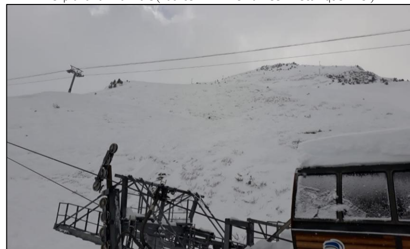
Figure 12 - Vue du versant naturellement purgé par l'avalanche en janvier 2021
