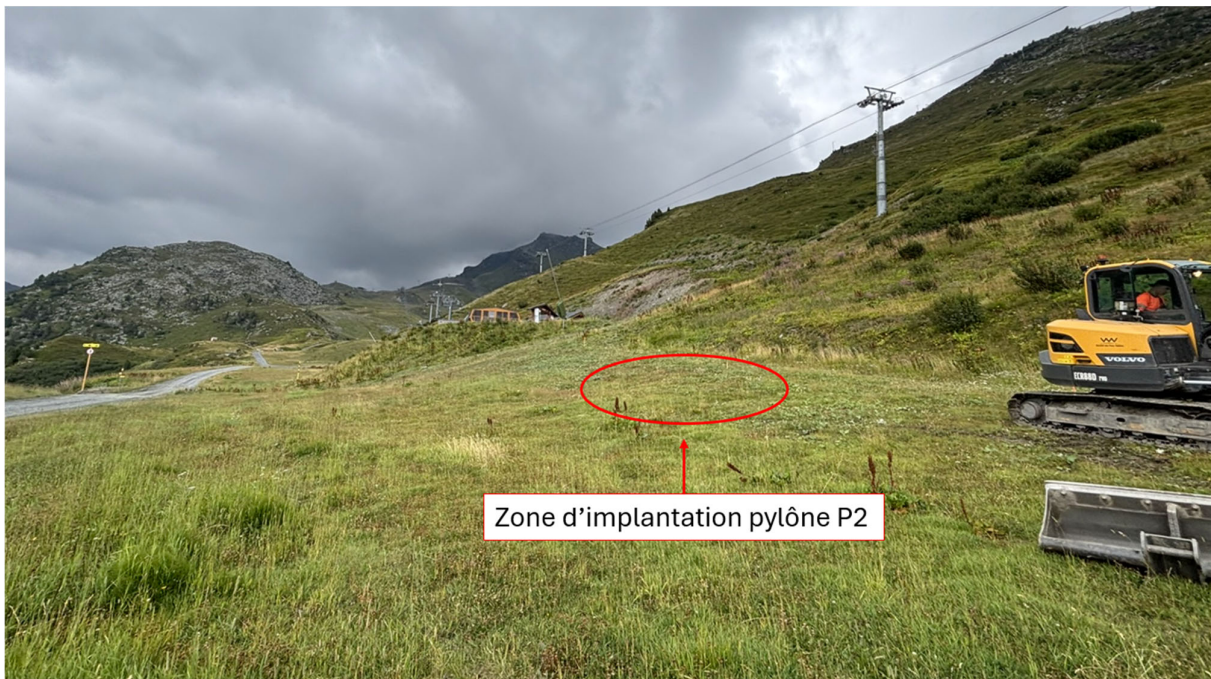
Figure 4 : Implantation du pylône P2 (Photographie 17/08/2026)
