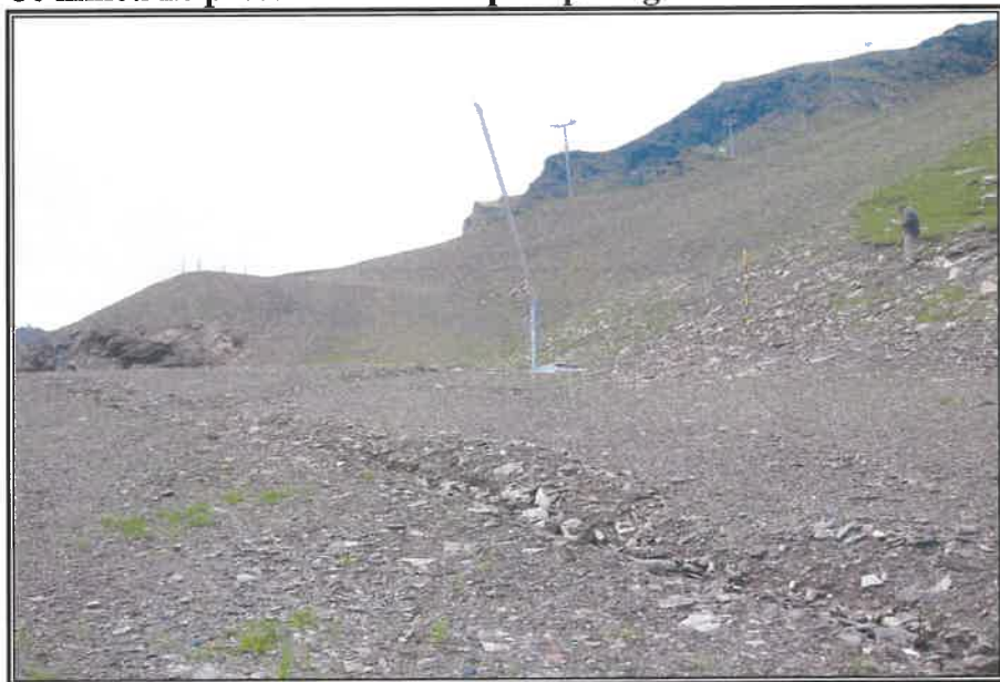
Cliché 1 : Secteur de la gare d'arrivée
