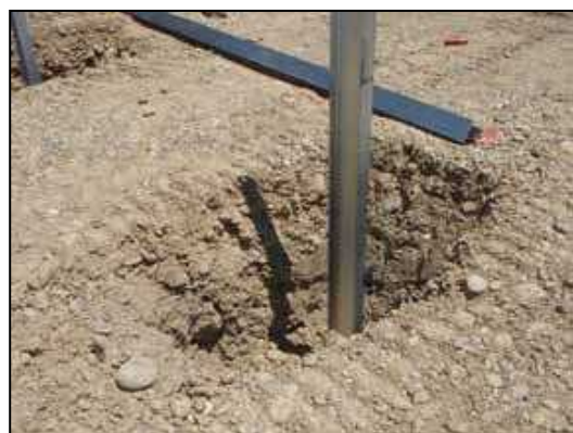
Figure 11 : Types de fondation - pieux battus (Source : Guide MEDDTL 2011 – NCA, 2015)
