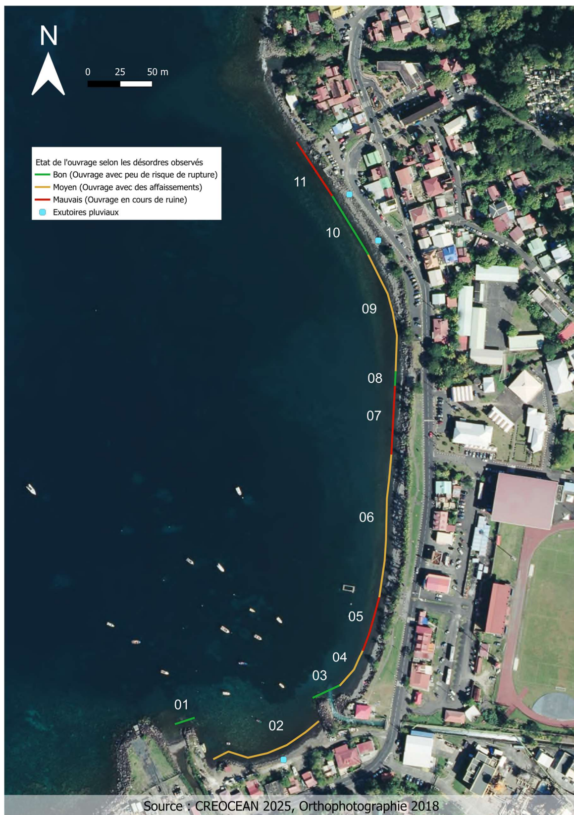
Figure 2-4 : Etat de l'enrochement du bourg de Bouillante, CREOCEAN 2025
