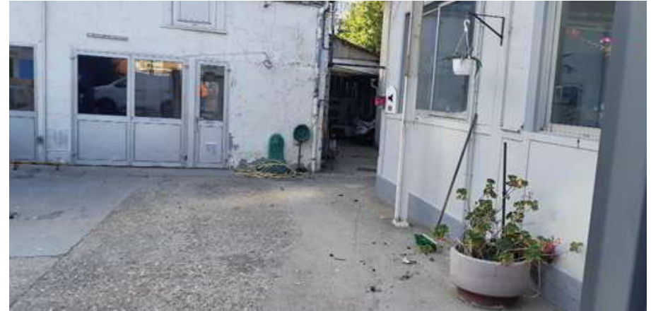
Cour avec enrobé bitumineux devant les bâtiments d'activité, parcelle G182 (sondage T1)
