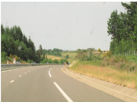
photo 16 : vues vers le site depuis la descente de l'autoroute dans le sens Sud/nord.
