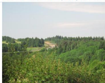
photo 10 : vue du site vers l'autoroute. On voit la descente et le pont du chemin rural de la Faye.
