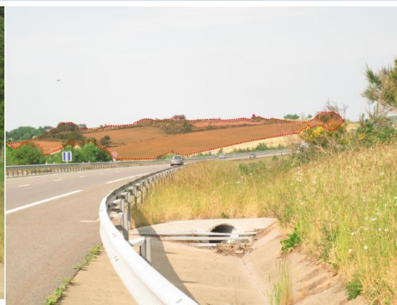
Report de l'emprise du site sur une photographie prise à 200 m plus bas sur la bande d'arrêt d'urgence
