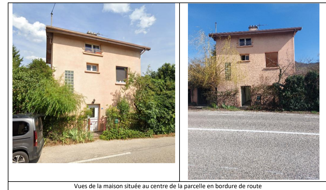
Figure 16 : Photos du site 3 – bâti
