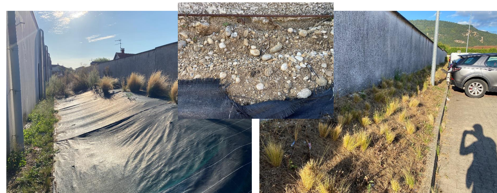
B : Talus avec plantations herbacées (en bordure de parking)
