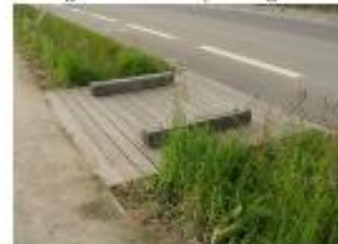
Passage sur noue en platelage
