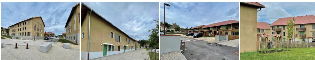
Opération réalisée en tranches 1 (îlots 1 et 2)
