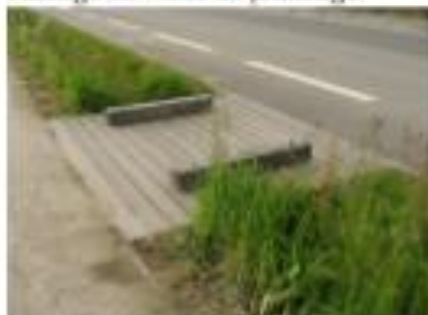
Passage sur noue en platelage
