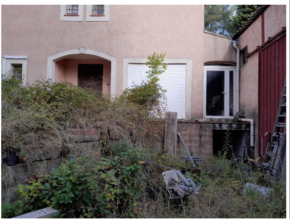
Parcelle 587 – Pavillon et entrée du vide de construction sur la droite
