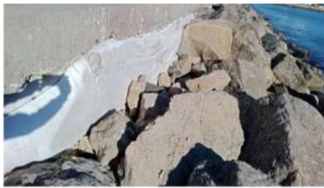
Cavité C17 après travaux
