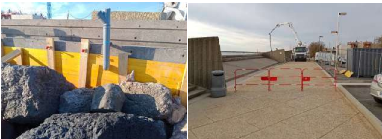
FIGURE 3 : TRAITEMENT DES CAVITES EN NOVEMBRE 2025
