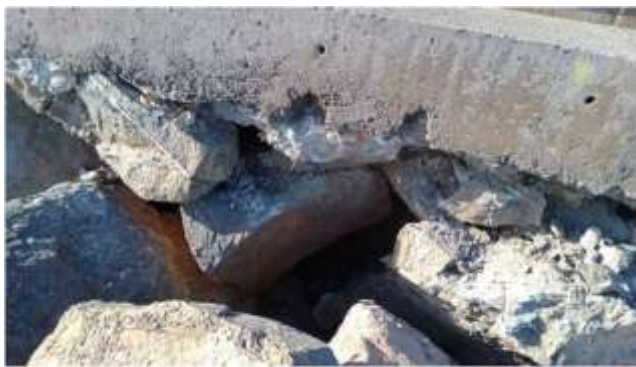
Cavité C17 avant travaux
