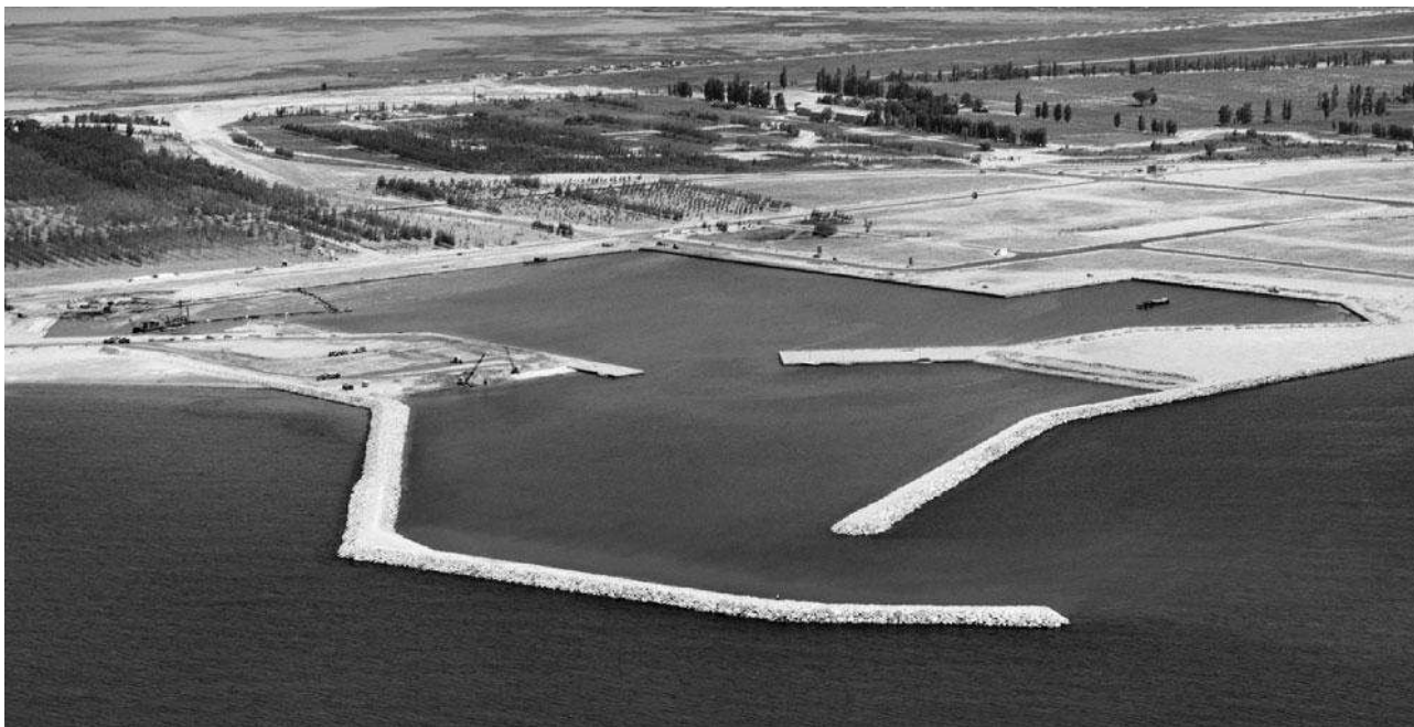
FIGURE 2 : PHOTOGRAPHIE DE LA CONSTRUCTION DU PORT (©SUGHRUE / MAIRIE DE LA GRANDE MOTTE)
