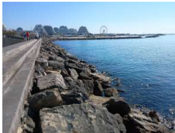
FIGURE 21 : ENROCHEMENT DE LA DIGUE
