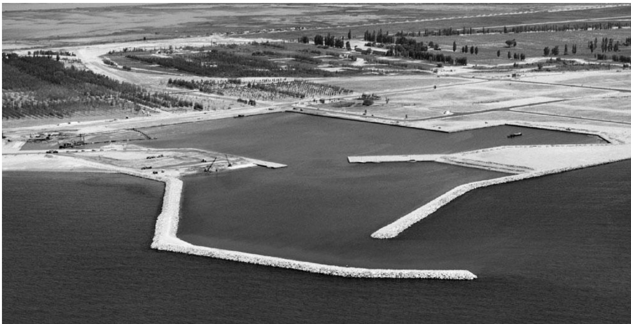
FIGURE 20. PHOTOGRAPHIE DE LA CONSTRUCTION DU PORT DE LA GRANDE MOTTE (©SUGHRUE / MAIRIE DE LA GRANDE MOTTE).
