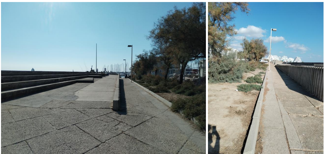
FIGURE 44. PHOTOGRAPHIES DE L'ARRIERE DE L'OUVRAGE ACTUEL AU NIVEAU DE LA RAMPE D'ACCES : (GAUCHE) VUE VERS LE PORT A L'OUEST ET (DROITE) VUE VERS L'EST
