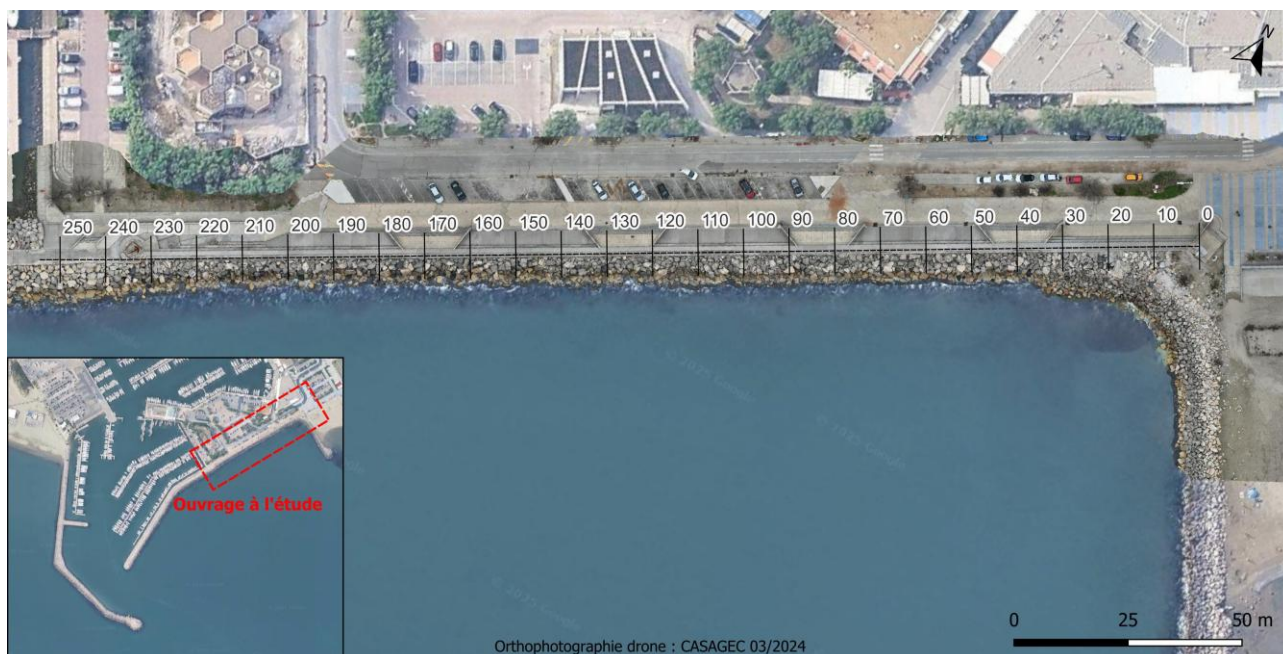
FIGURE 1. LOCALISATION DE L'OUVRAGE DE PROTECTION MARITIME DE LA PROMENADE EST DU PORT DE LA GRANDE MOTTE
