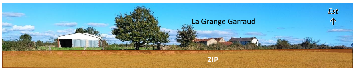
Figure 41 : Photo 28 : Ferme de la Grange Garraud
