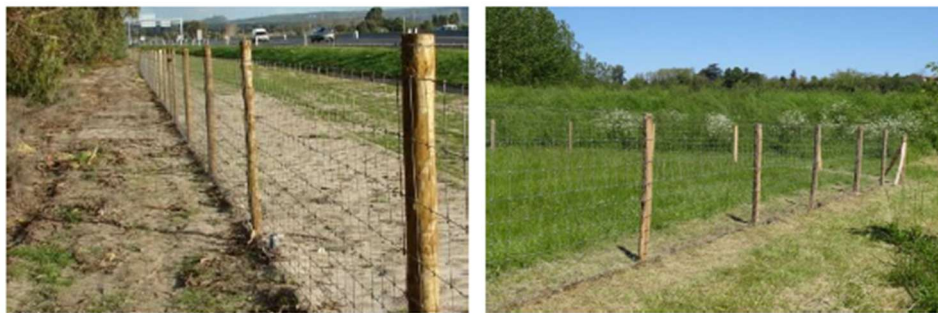
Figure 8 : Exemple d'une clôture de parc solaire
