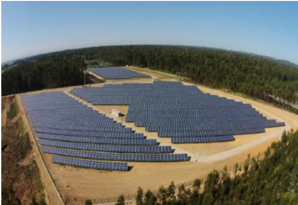
Figure 5 : Exemple d'un parc solaire au Portugal (4,5 MWc) Source : EDPR
