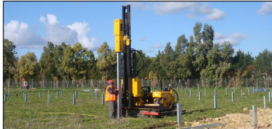
Figure 28 : Sonnette de battage hydraulique
