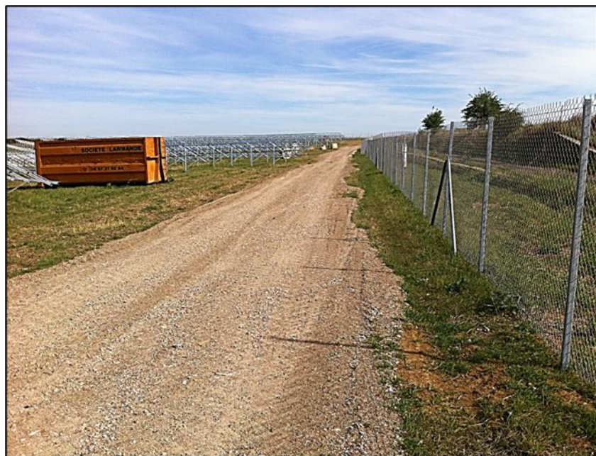
Photo 6 : Exemple d'une bande de roulement adaptée aux véhicules lourds
