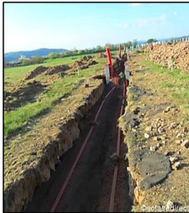
Photo 4 : Tranchée pour câblage
