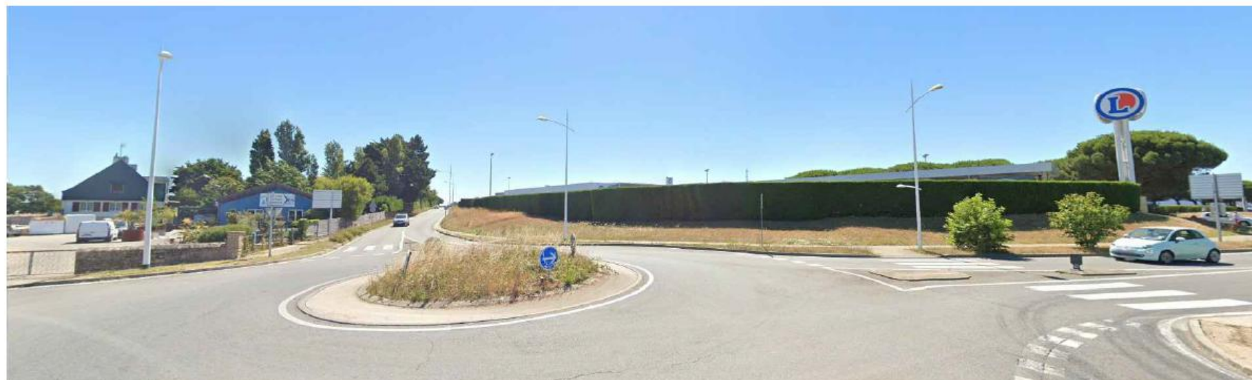
Vue sur l'extension Nord depuis le rond point route Sandun / rue des Pâtis_Avant
