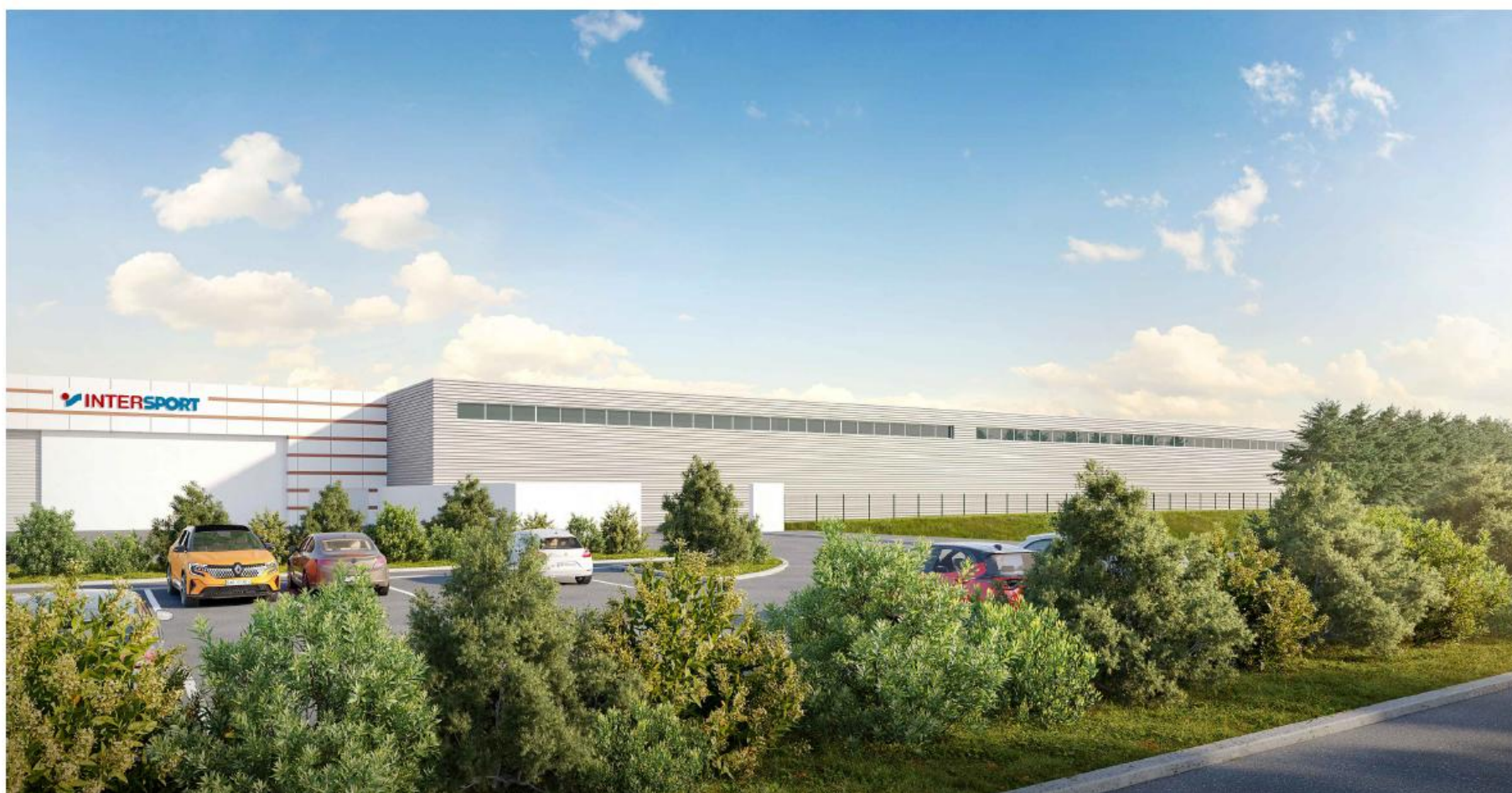
Vue sur l'extension Est _Après
