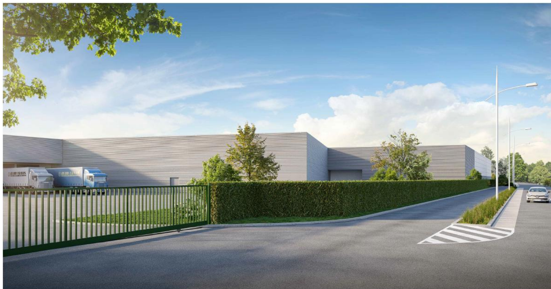
VUE sur l'extension Est depuis la route Sandun- Après
