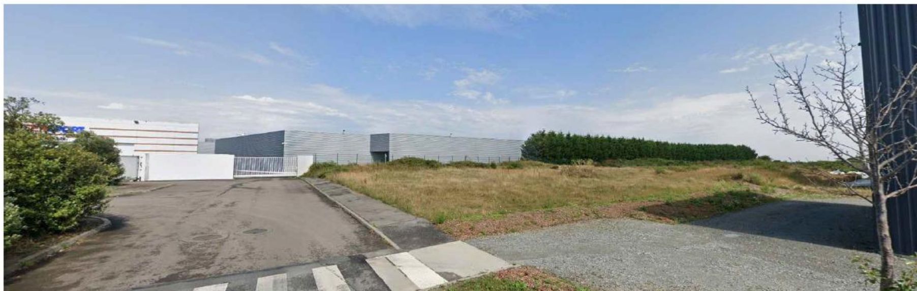
Vue sur l'extension Est _Avant
