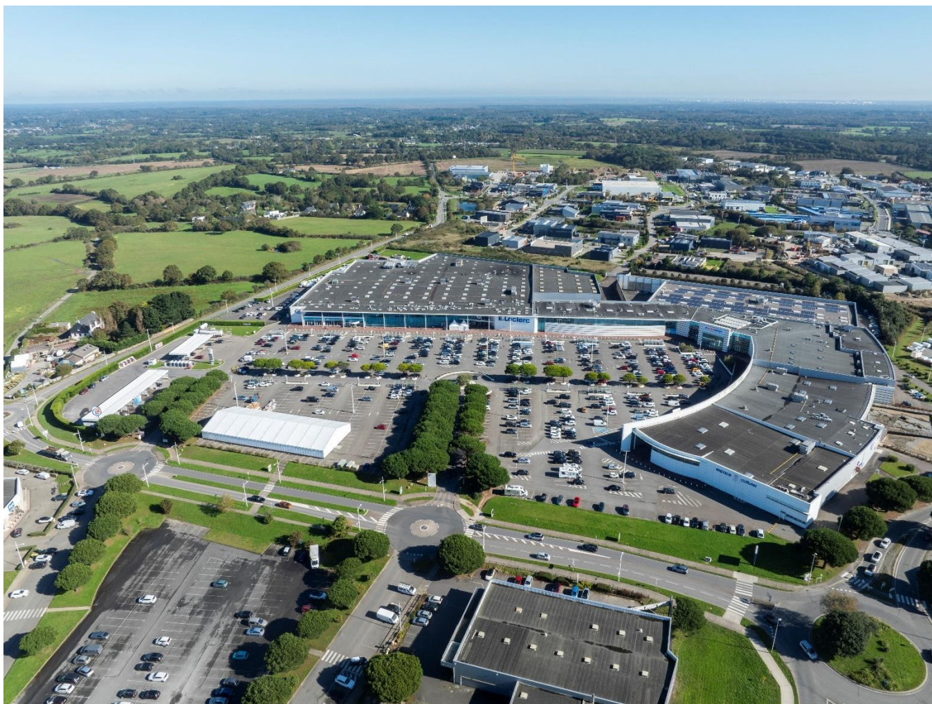
Vue actuelle du centre commercial
