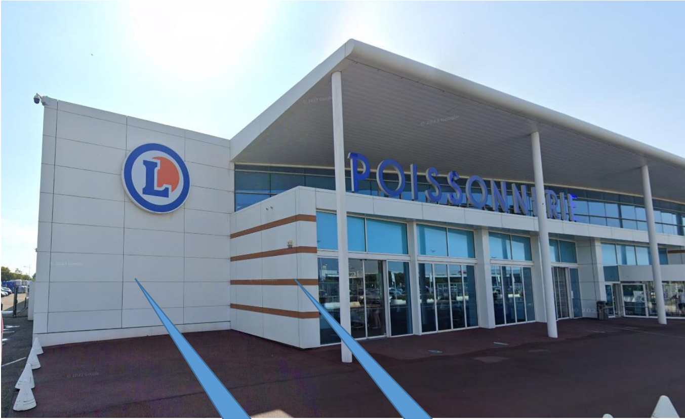
Vue façade Ouest existante
