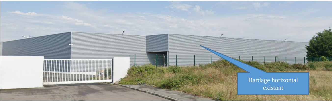
Vue façade Est existante
