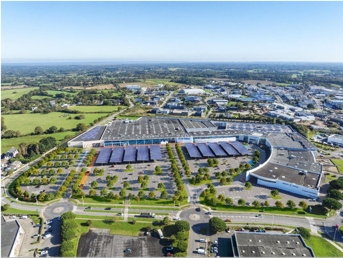
Vue aérienne Ouest du projet
