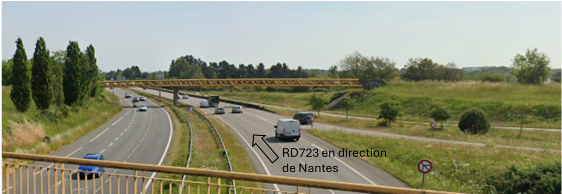
Photographie 2 : Vue depuis le pont surplombant la RD723 entre les ronds-points des écuries et de la Ville au Denis (source : Google street)
