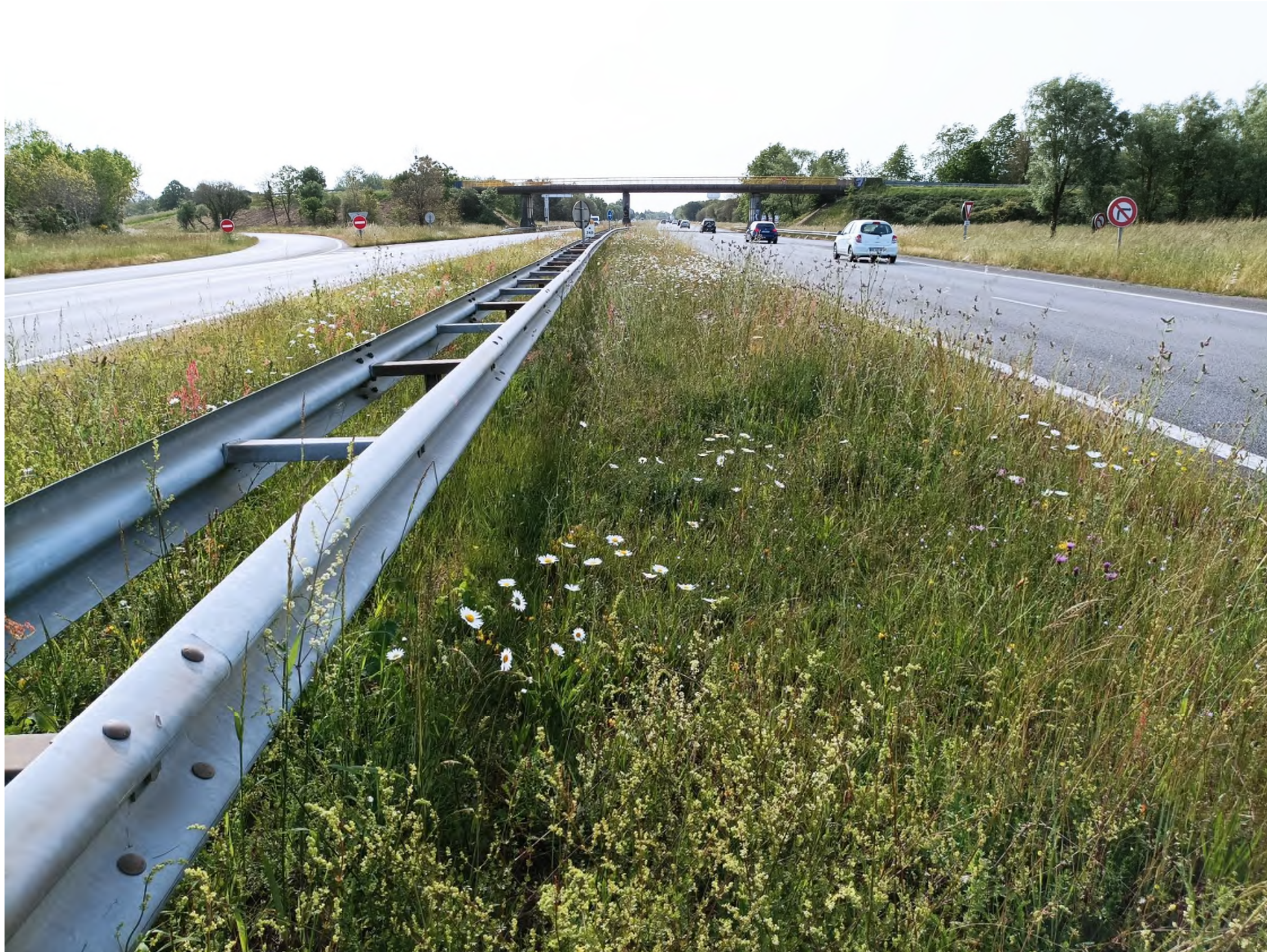
Photographie 1 : Vue depuis le terreplein central de l'axe de la RD723 en direction de Nantes (SCE)
