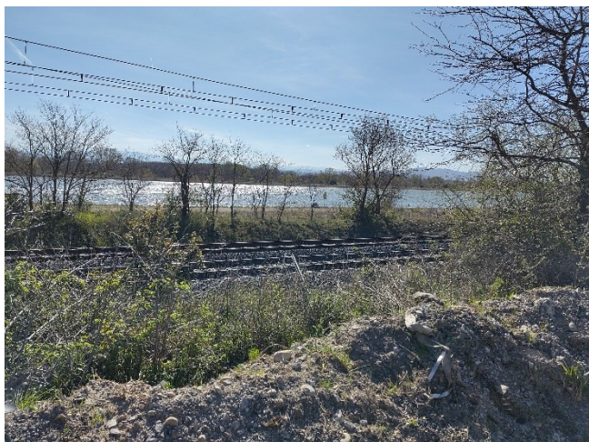
VUE SUR LA VOIE FERREE A L'EST ET LE CANAL DU RHONE
