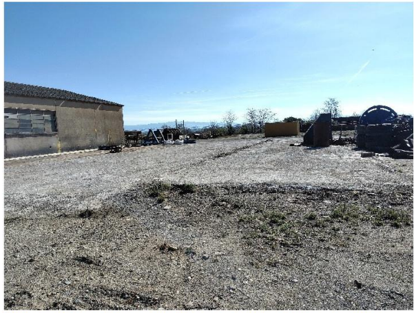
PLATEFORME EN BETON UTILISEE COMME ESPACE DE DEPOT DE MATERIAUX ET PARKING
