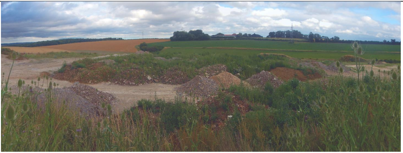
Vue du remblai en cours
