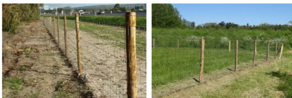
Exemple d'une clôture de parc solaire
