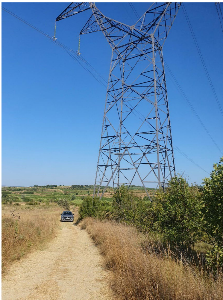
Photo du site – Source : Melvan, 2026
