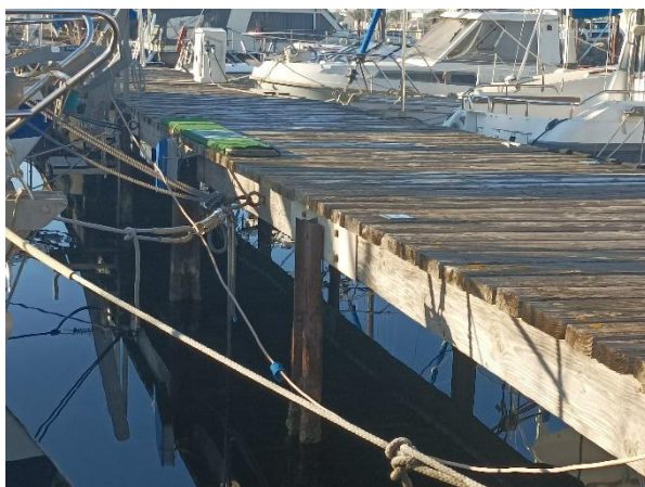
Figure 1-10 : Reprise de la fixation du ponton/pieux (CREOCEAN, 2022)
