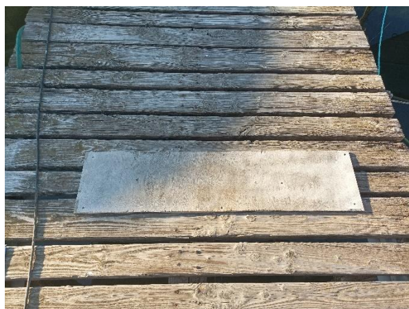
Figure 1-7 : Réparation sommaire du platelage (CREOCEAN, 2022)
