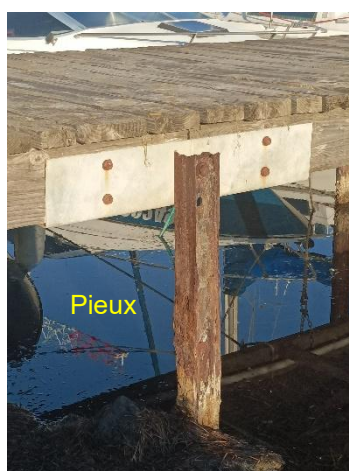
Figure 1-6 : Fixation du pieux sur l'ossature bois du ponton (CREOCEAN, 2022)
