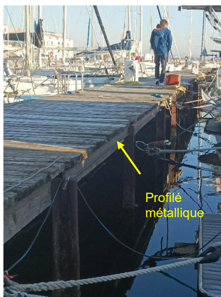
Figure 1-11 : Confortement du ponton par la mise en œuvre d'un profilé métallique (CREOCEAN, 2022)
