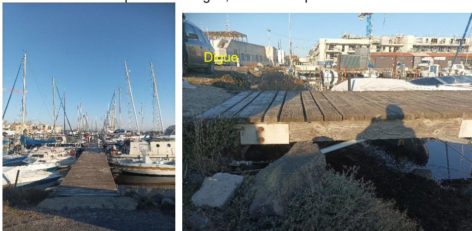
Figure 1-5 : Vue générale du ponton depuis la digue (CREOCEAN, 2022)
