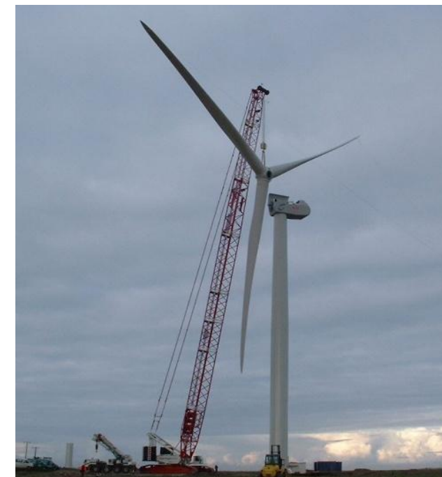
IMAGE 6 MONTAGE DU ROTOR
