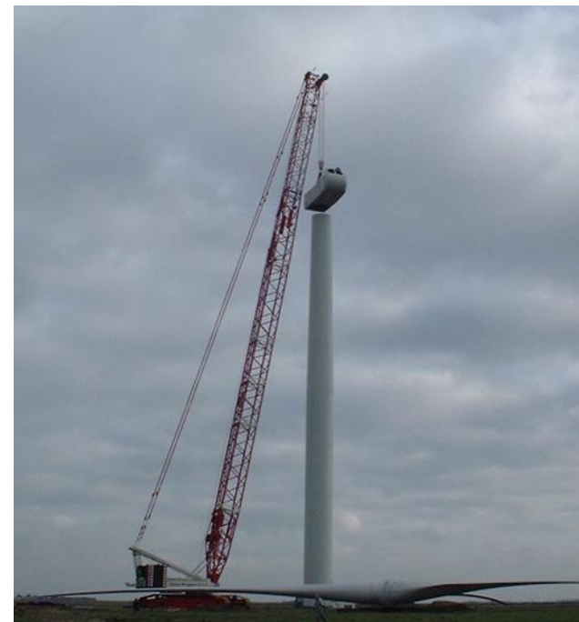
IMAGE 5 MONTAGE DE LA NACELLE
