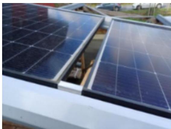
Figure 9: Exemple d'espace laissé entre les modules
