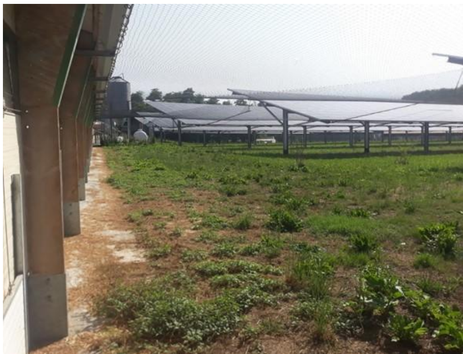
Figure 22 : Photographie d'une volière agrivoltaïque de Mexens dans le cas d'un élevage de poulets de chair, avec à gauche le bâtiment d'élevage relié directement aux panneaux solaires et à la clôture périphérique, formant un clos total.
