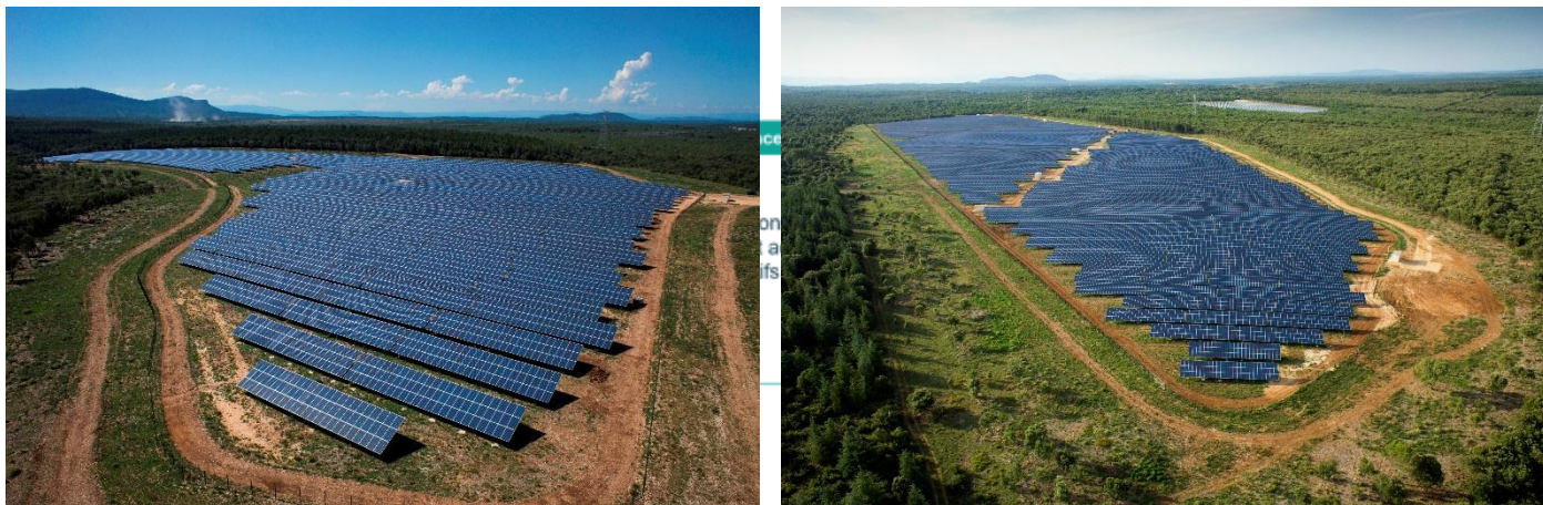
Figure 4 : Centrale solaire de Belvesol dans le Gard (20 MWc)
