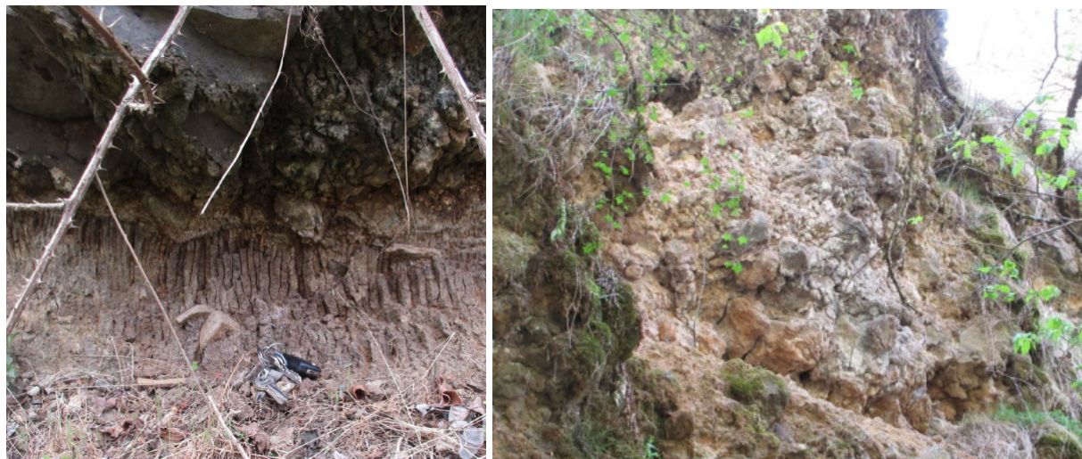
Prisme d'argiles à l'entrée du PPI Besson ; brèches hydromagmatiques au sud du centralisateur proche des captages du Roulon (B Montorier)
