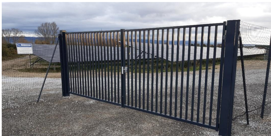
Figure 3 : Exemple de portail permettant d'accéder au site
