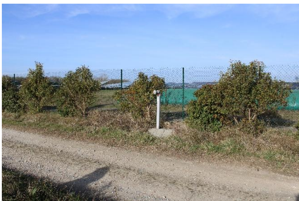
Figure 4 : Exemple de prise d'eau à l'extérieur clôturée du parc photovoltaïque
