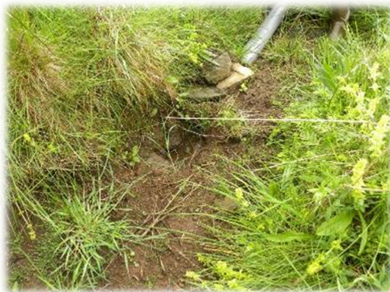
Cliché du 23/05/2023 montrant l'ancienne "galerie de captage" en pierre basaltique, et canalisation de prélèvement
