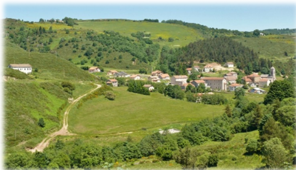
Photographie du village de Cros-de-Géorand (source : Commune du Cros-de-Géorand)
