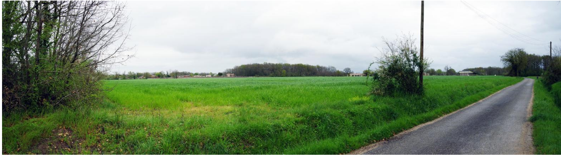
Figure 16 : Vue 1 - état initial
