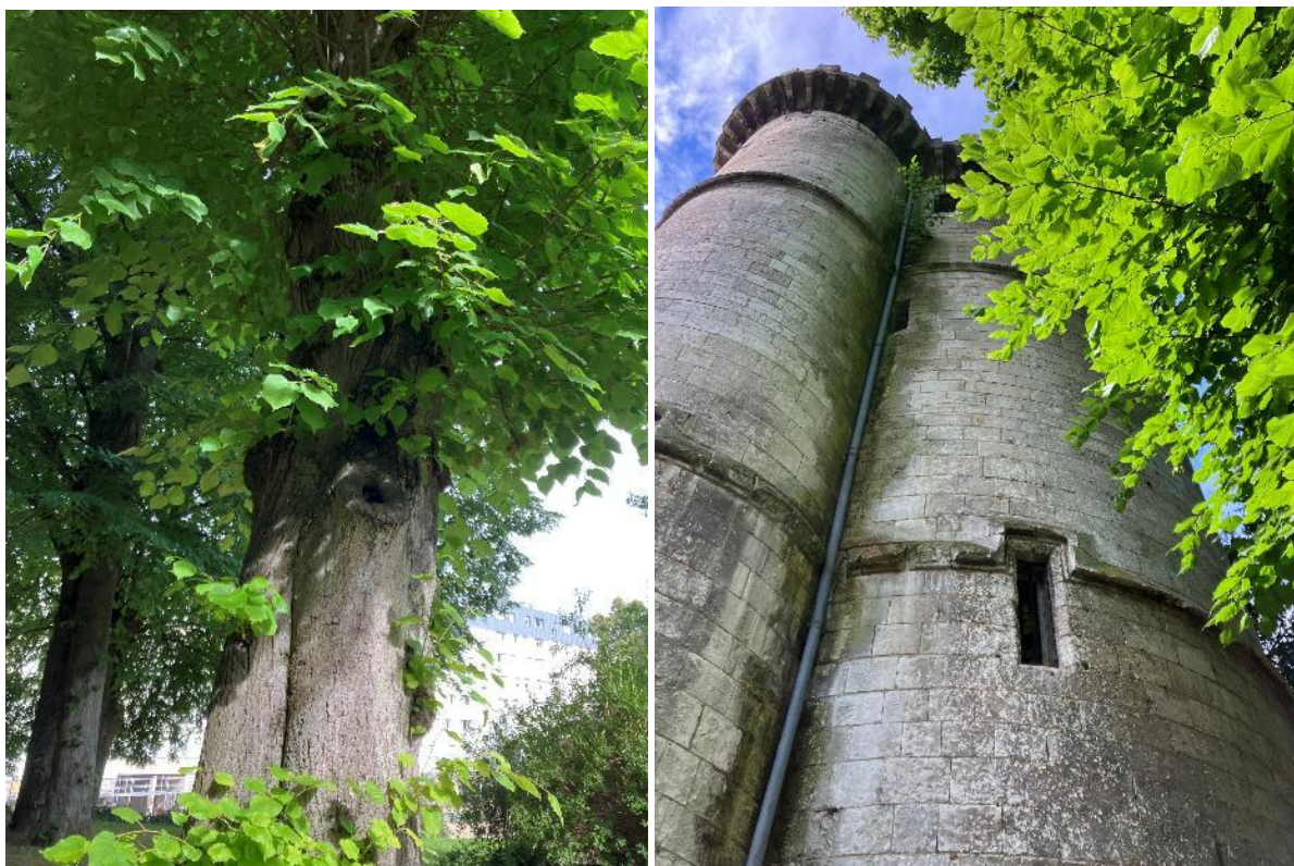
Figure 25 : Gîtes potentiels sur le site (cavités dans les vieux arbres du parc sur la photo de gauche – Fenêtres avec les carreaux cassés sur la photo de droite)
