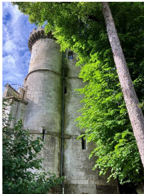
Structure bâtie : Tourelle
