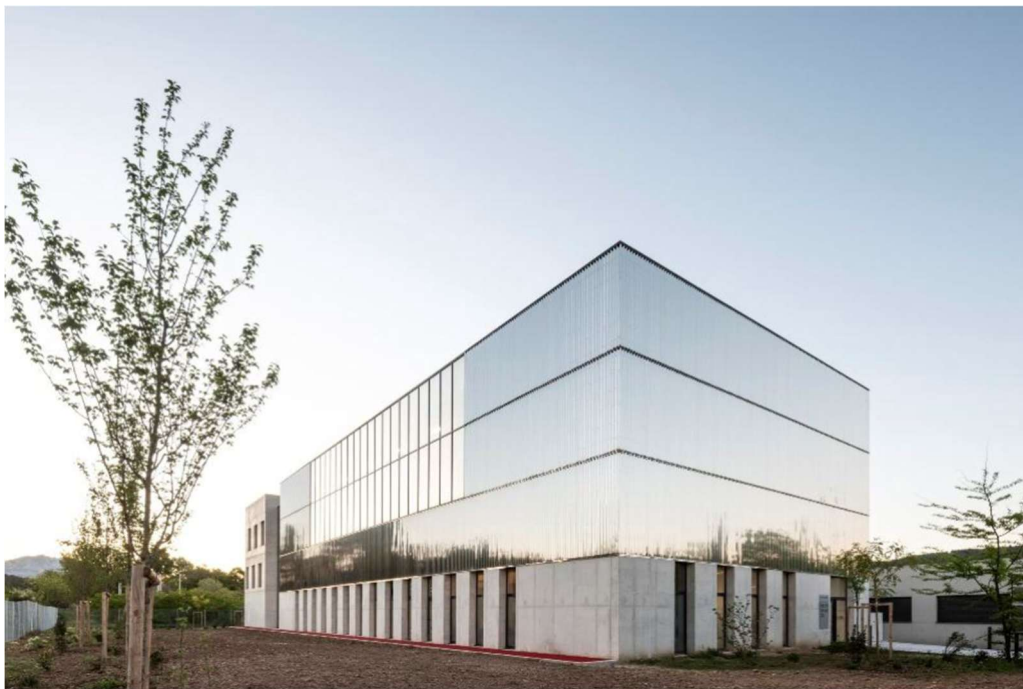
Figure 59 : Exemple de réalisation de bâtiment revêtu de lames en métal poli.
