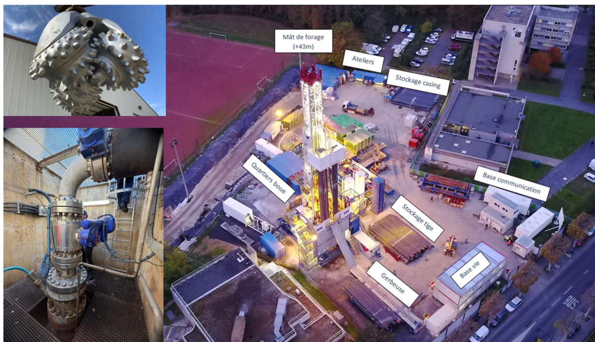
Figure 52 : implantation d'un chantier de forage sur 5000m 2 - image du trépan et de la tête de puits en exploitation (Cachan – Dalkia 2016)
