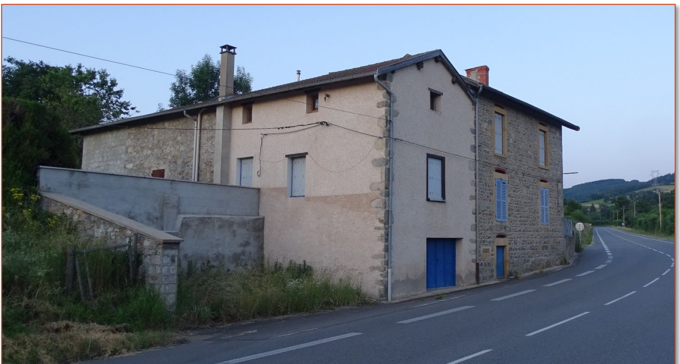
Figure 7. Vue du bâtiment depuis le sud-ouest
