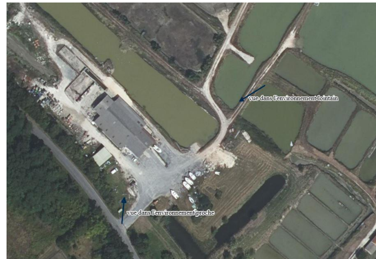
Vue dans un environnement lointain
