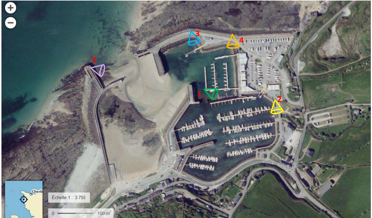
Figure 10 : Prises de vues – Visite du 21/04/2026. Source : TBM environnement.
