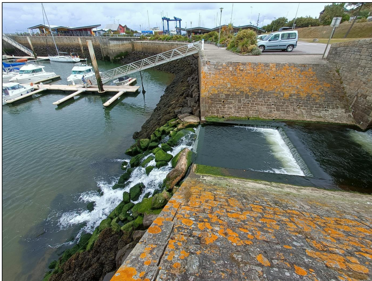
Figure 4 : Vue de l'exutoire de la rivière la Diélette © TBM environnement 2026.
