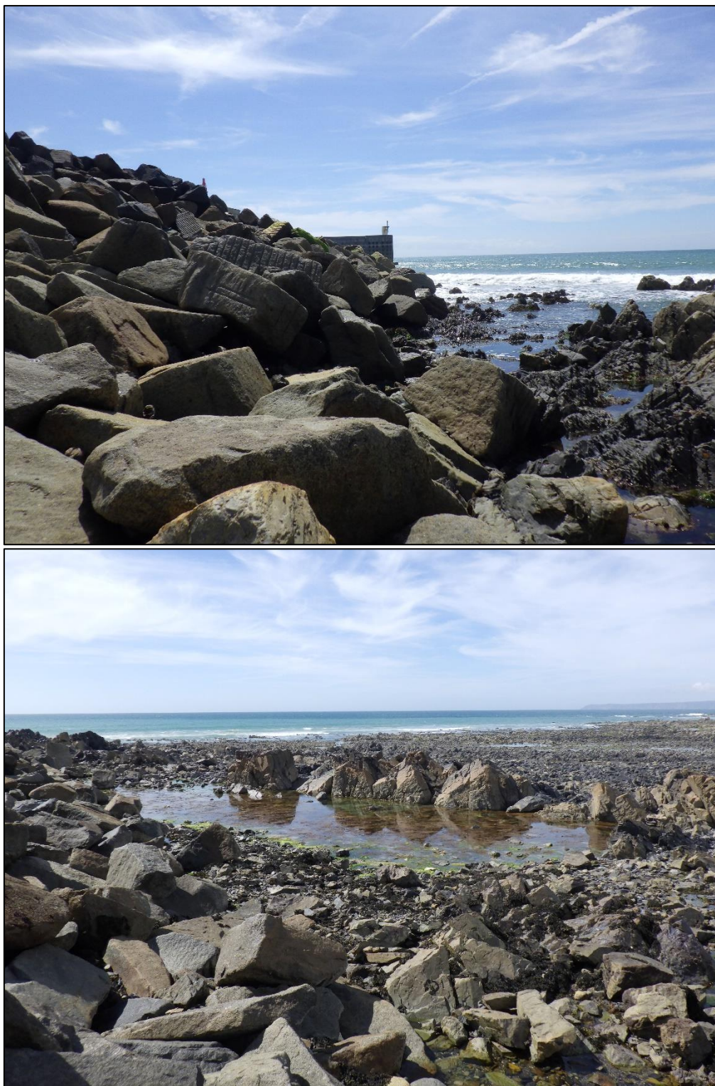
Figure 10 : Illustration de l'interface entre la digue nord artificielle du port de Diélette et l'estran rocheux naturel © TBM environnement 2026.
