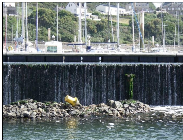
Figure 34 : Côté extérieur du mur submersible du port de Diélette © TBM environnement 2026.
