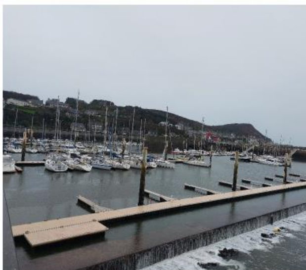
Figure 12 : Mur submersible. Source : © TBM environnement 2026.
