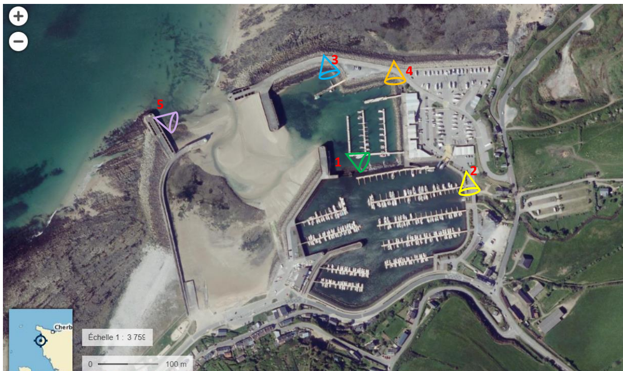
Figure 10 : Prises de vues – Visite du 21/04/2026. Source : TBM environnement.
