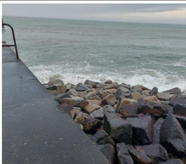
Figure 14 : Digue nord. Source : © TBM environnement 2026.
