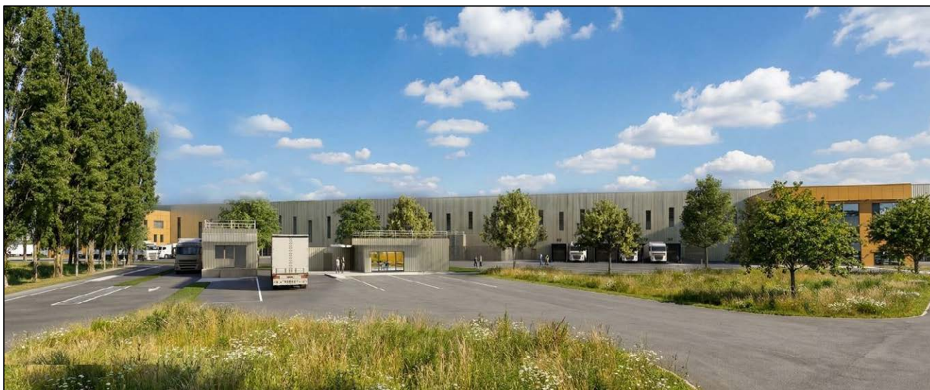
Figure 59 : Vue de la façades Est de l'entrepôt depuis l'accès de l'AltaParc Confluence II – SARL François DE LA SERRE
