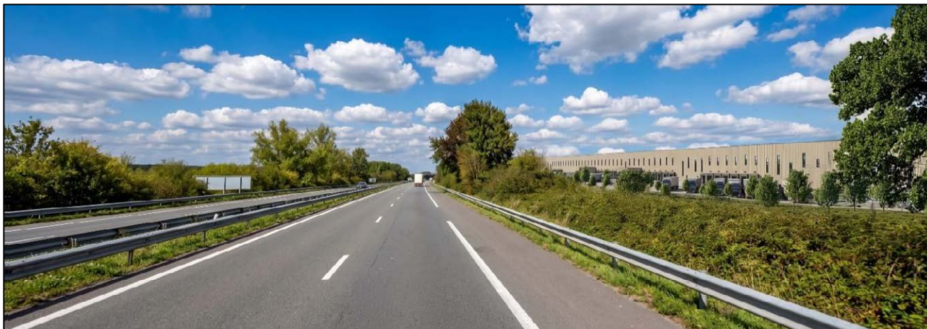
Figure 60 : Vue de la façade Ouest de l'entrepôt depuis l'A62 – SARL François DE LA SERRE
