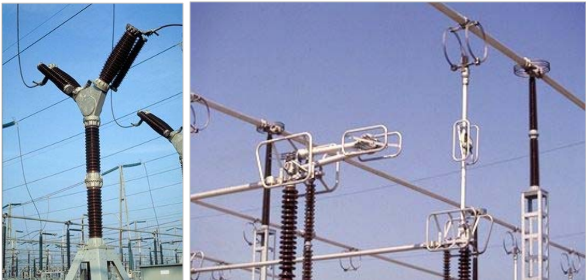
Figure 6 | Disjoncteur (à gauche) et sectionneur (à droite) d'un poste électrique
