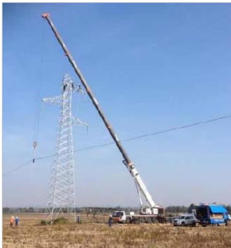
Figure 14 | Levage des supports à la grue
