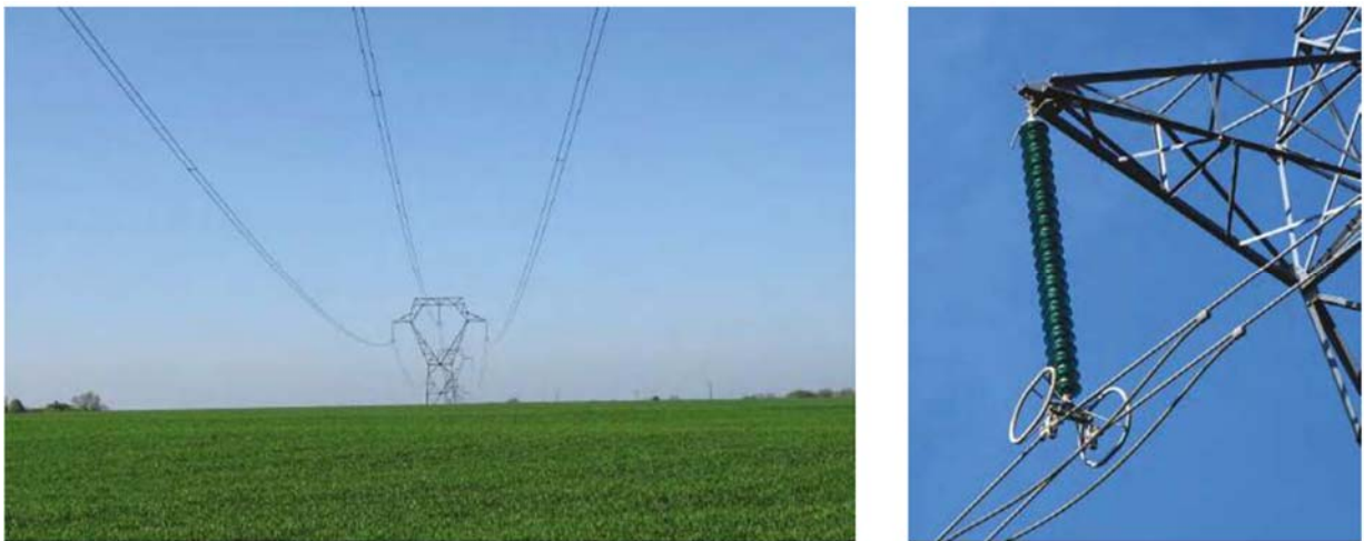
Figure 9 | Câbles conducteurs et chaîne d'isolateurs
