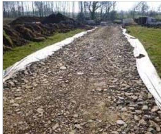
Figure 11 | Piste provisoire sur géotextile
