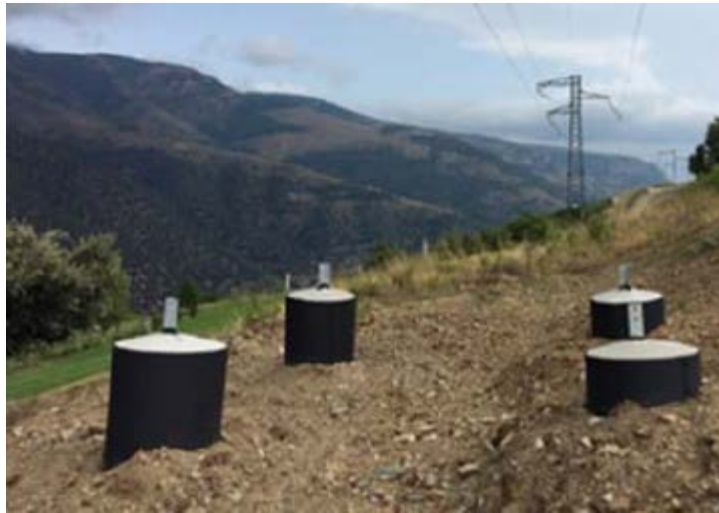
Figure 17 : Exemple de fondations neuves
