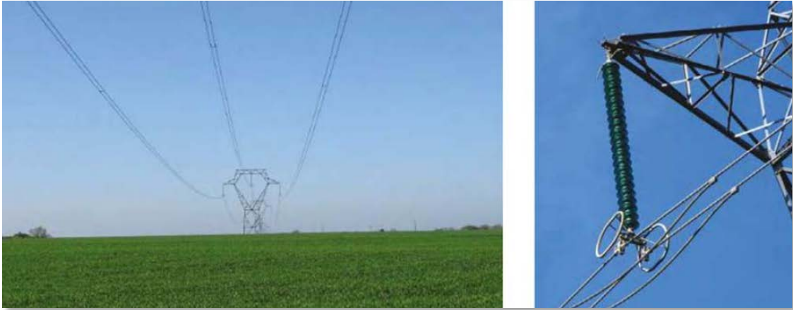
Figure 15 : Câbles conducteurs et chaîne d'isolateurs
