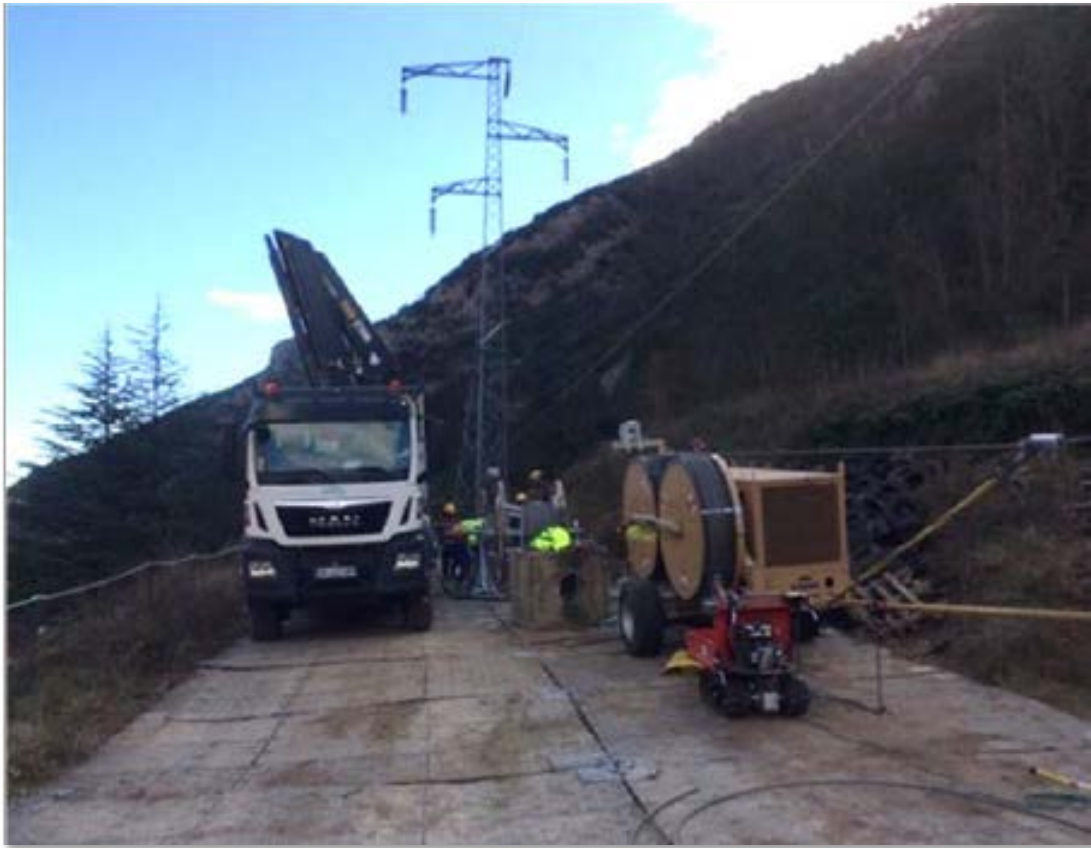
Figure 16 : Exemple d'une plateforme de déroulage
