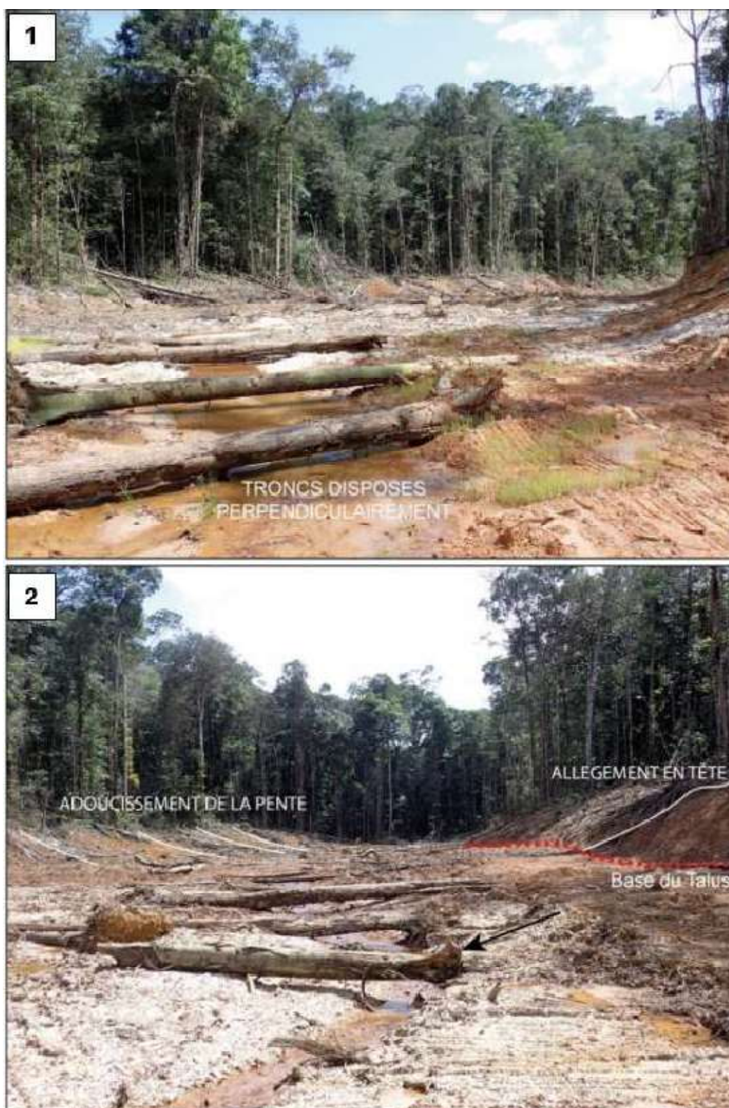
Figure 1 – AEX Aviosa 1 : exemple de remise en état d'un flat alluvionnaire d'environ 35 m de largeur entre deux massifs forestiers. Cette configuration est comparable, et plus contrainte, que celle rencontrée sur la partie amont du projet Alphonsin Aval.
