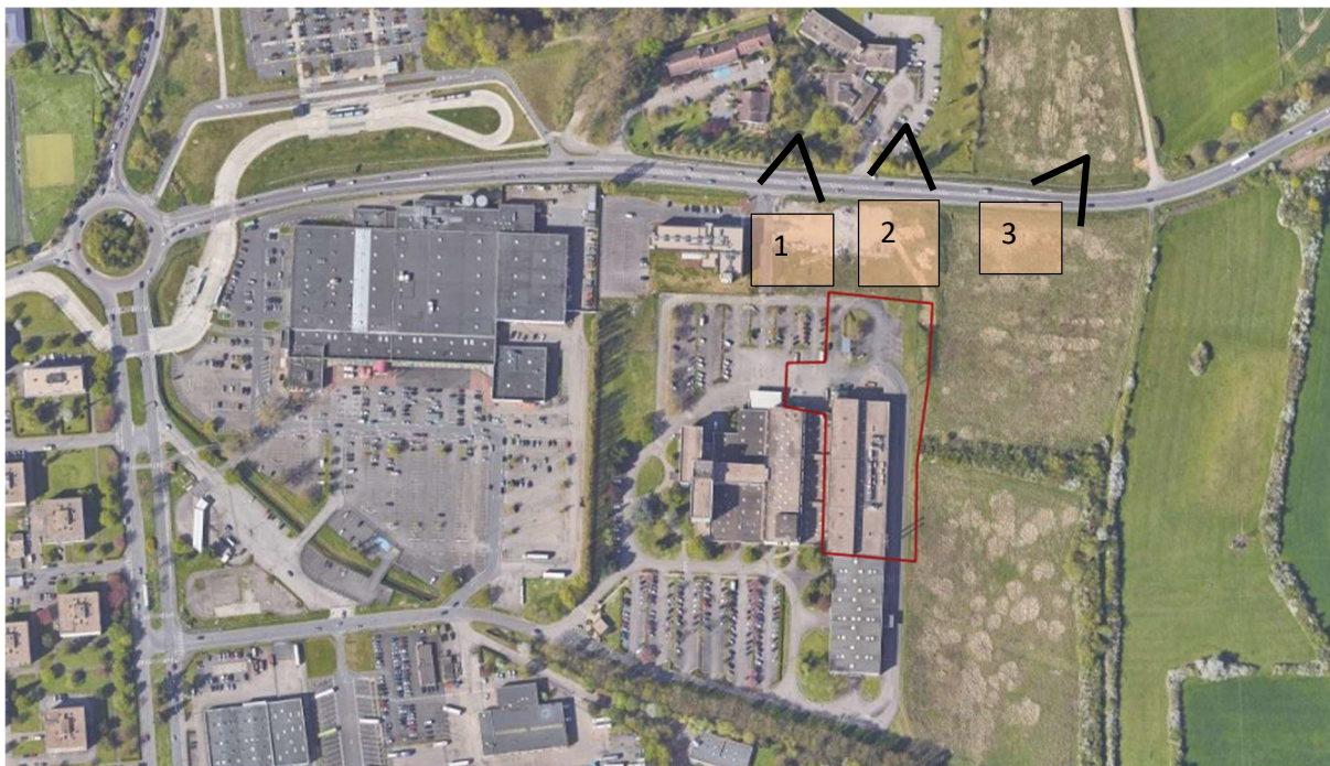
Vue aérienne de l'emprise du projet (Source : géoportail)
