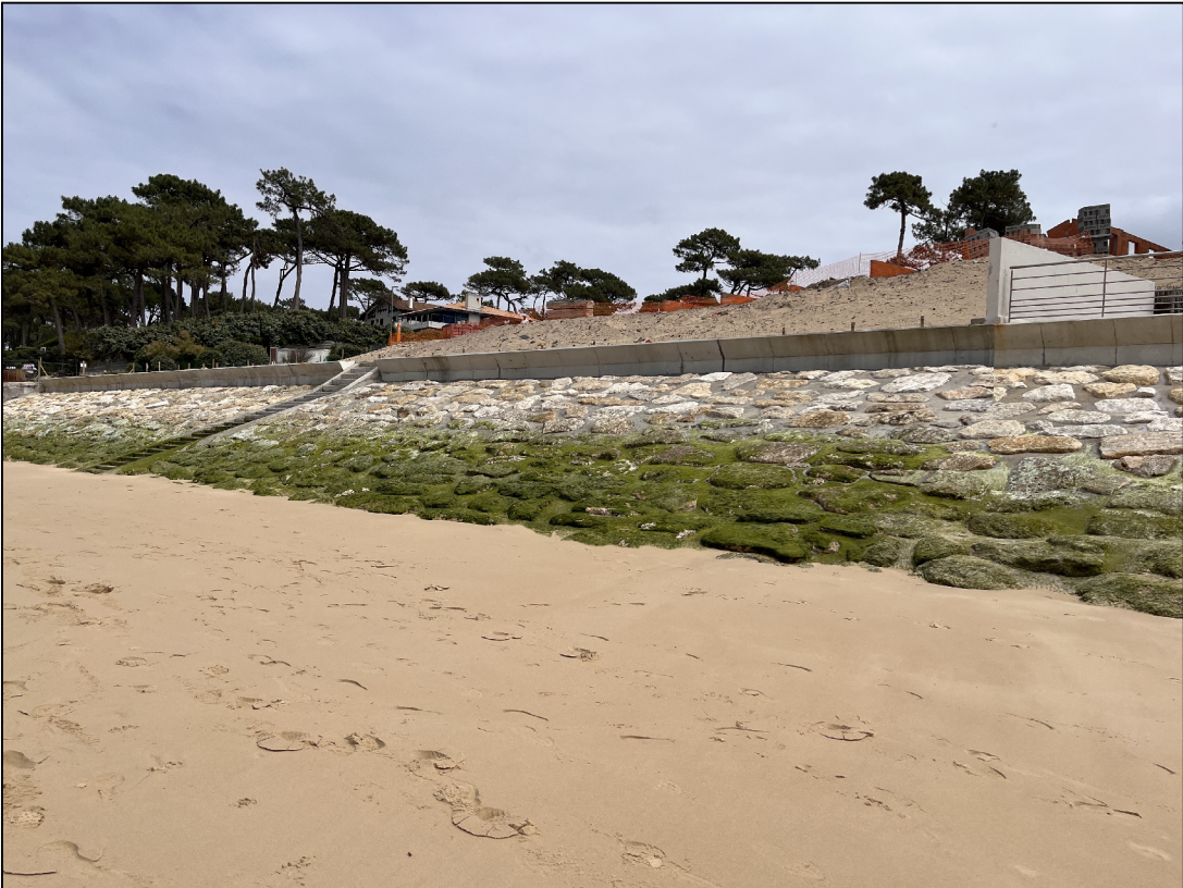
Photo Projet Aménagement
